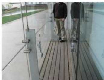
Colocación de sensores de superficie de muro cortina Nexus II
