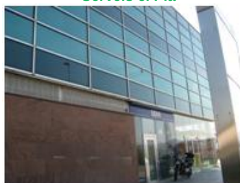
Sensores de superficie en Centre de Serveis el Pla
